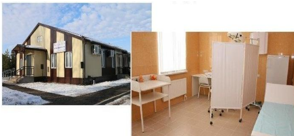
Рисунок 5. Общий вид здания СВА, ФАПа и одного из его помещений
